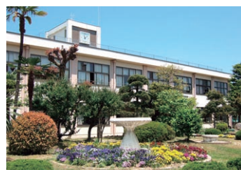
附属小学校 Elementary School
