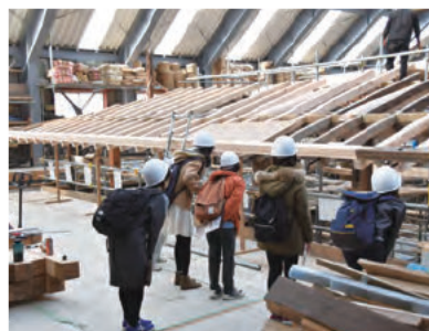
文化財の改修現場の見学
